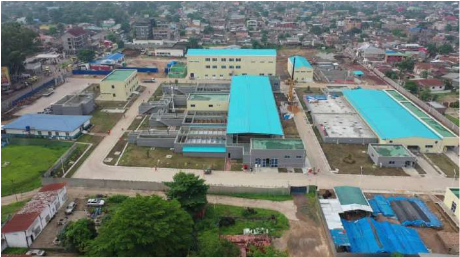
Phase 1 de l'Usine de traitement d'Ozone
