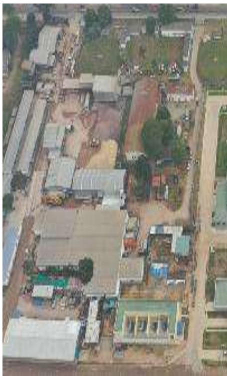
Site du Module 3 de l'Usine de traitement d'Ozone avant les travaux
