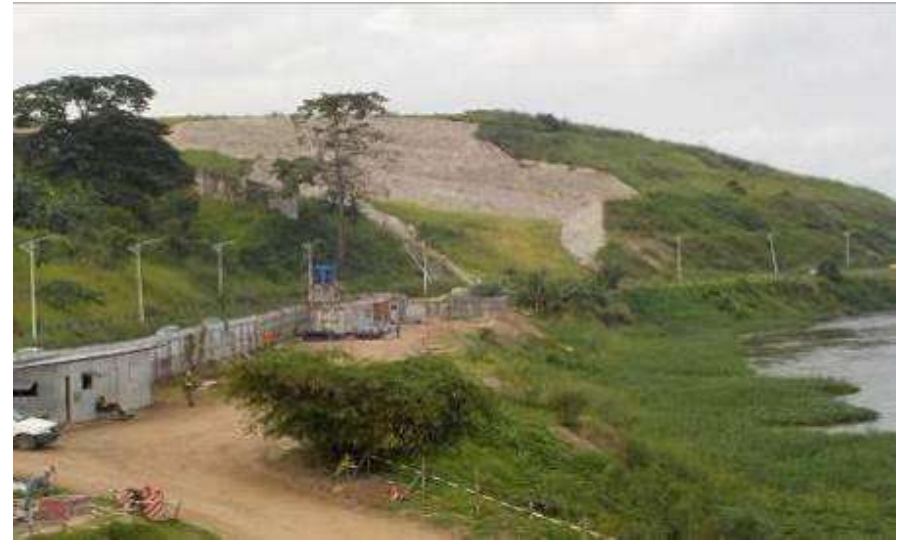
Site de pose de la DN 1800
