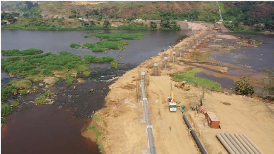
Travaux de pose de la conduite de rejet des boues dans le Fleuve Congo
