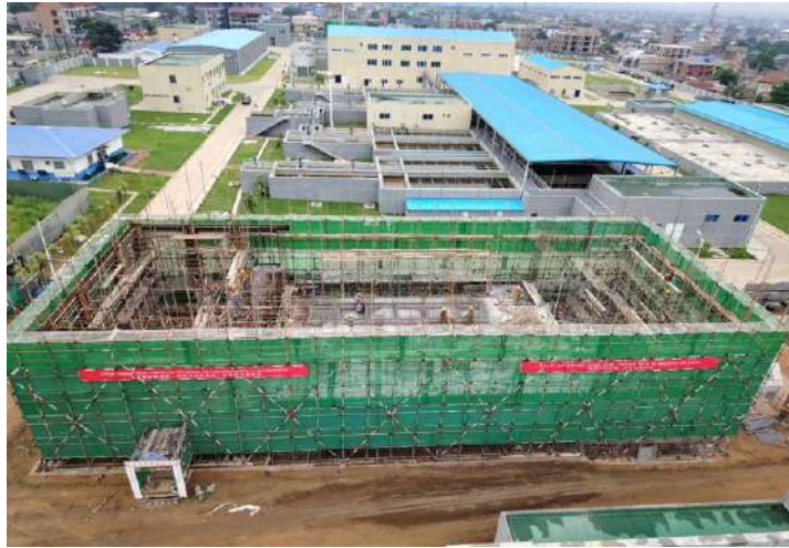
Vue aérienne du bâtiment des réactifs du Module 3
