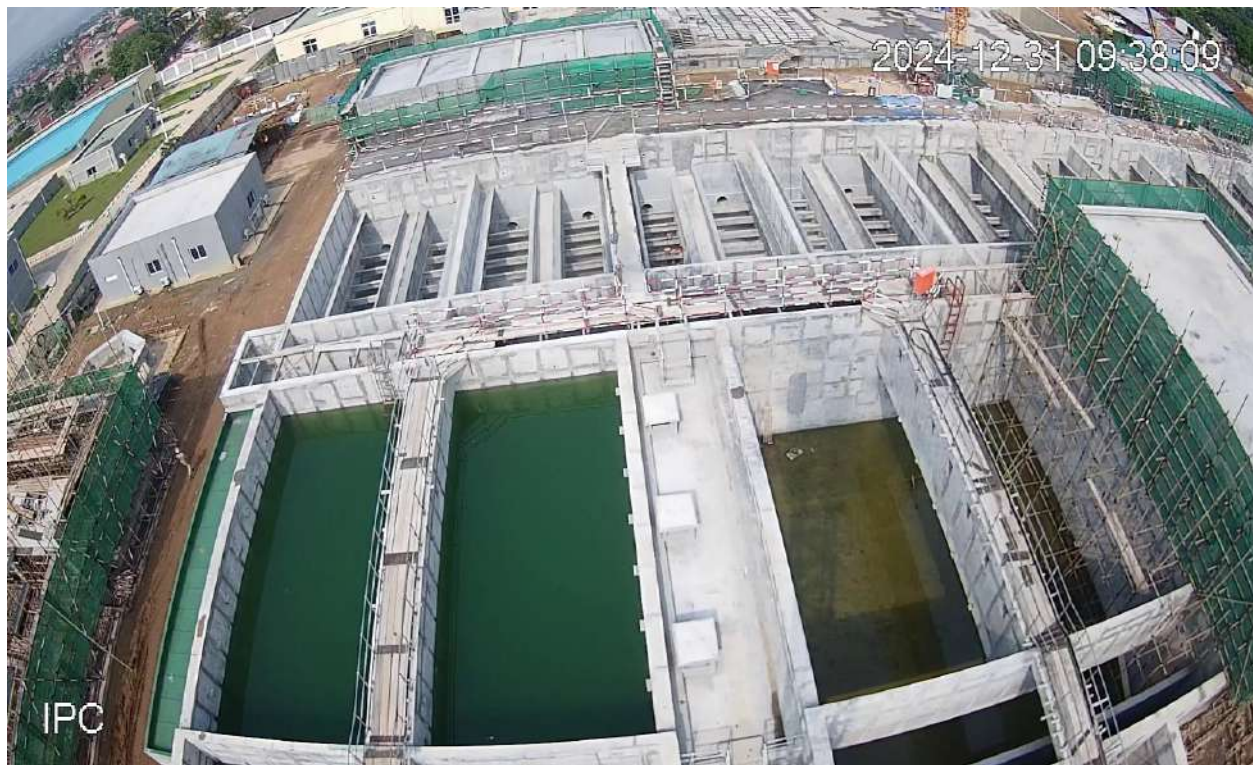
Site du Module 3 de l'Usine de traitement d'Ozone en cours d'exécution
