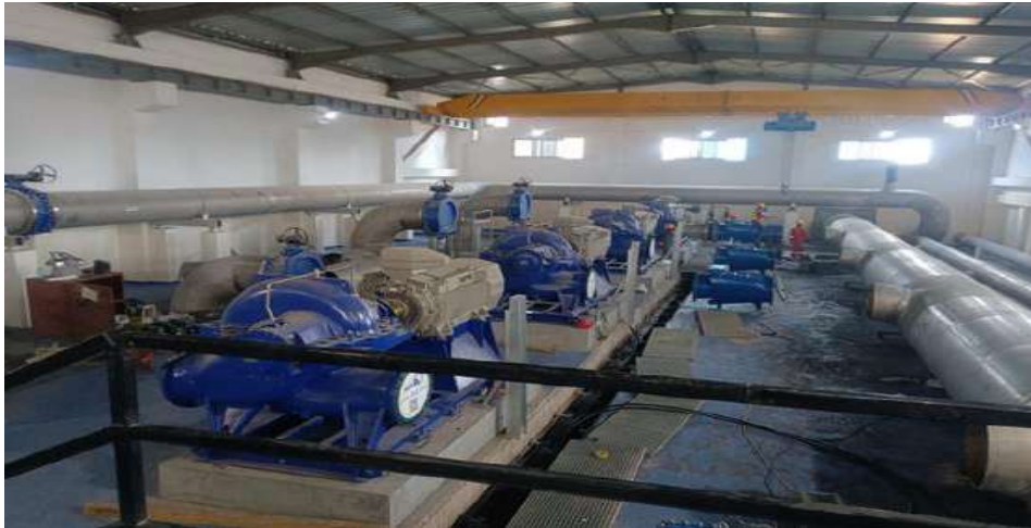
Montage en cours des pompes d'eau traitée
