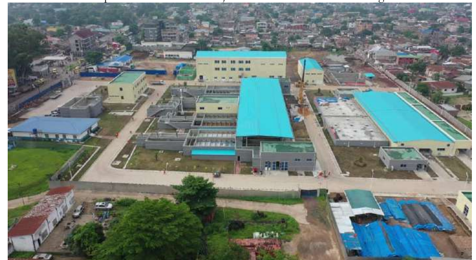
Phase 1 de l'Usine de traitement d'Ozone
