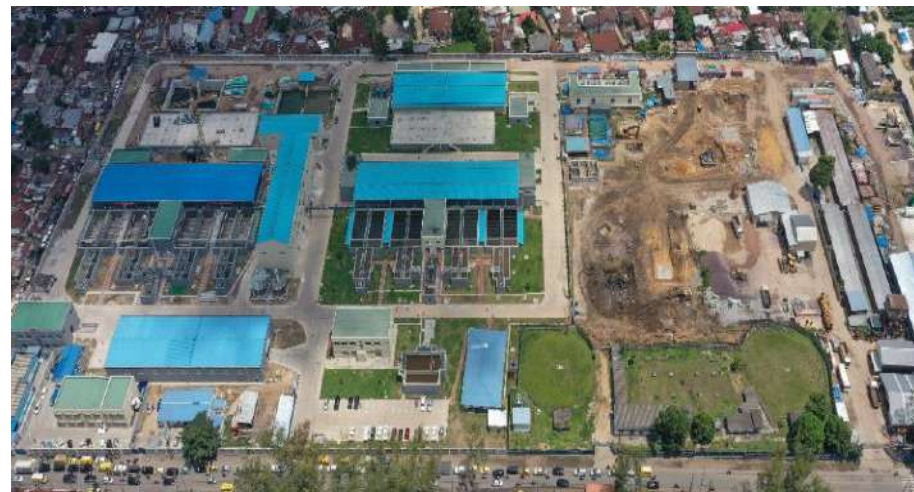
Vue plongeante des 3 modules
