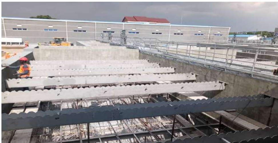
Montage des goulottes des décanteurs
