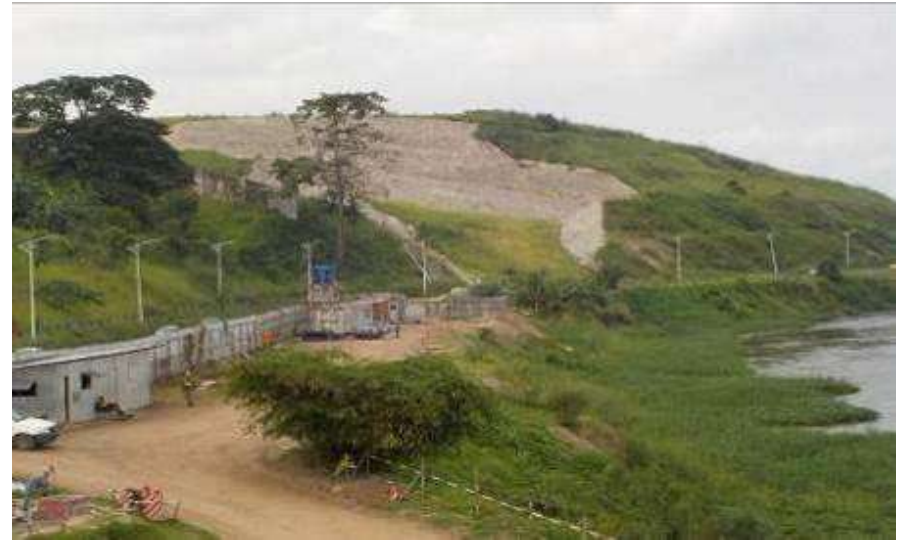
Site de pose de la DN 1800
