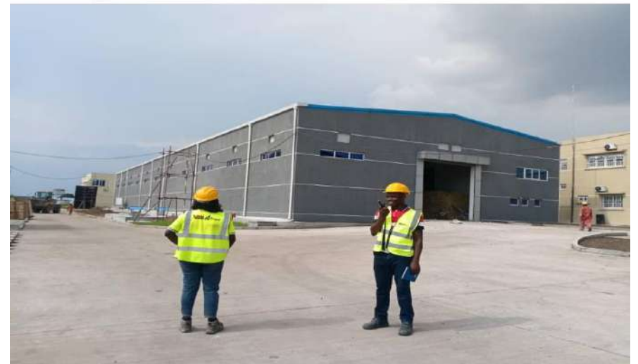
Voirie et entrepôt des réactifs
