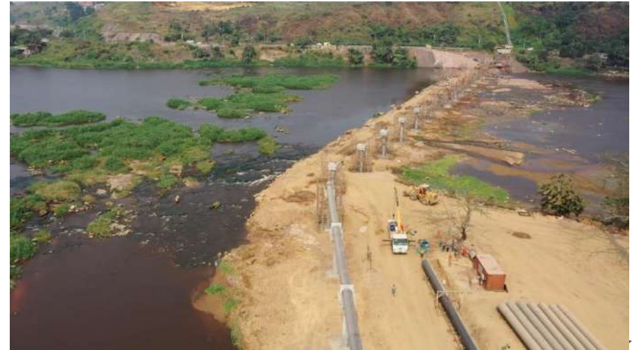
de pose de la conduite de rejet des boues dans le Fleuve Congo
