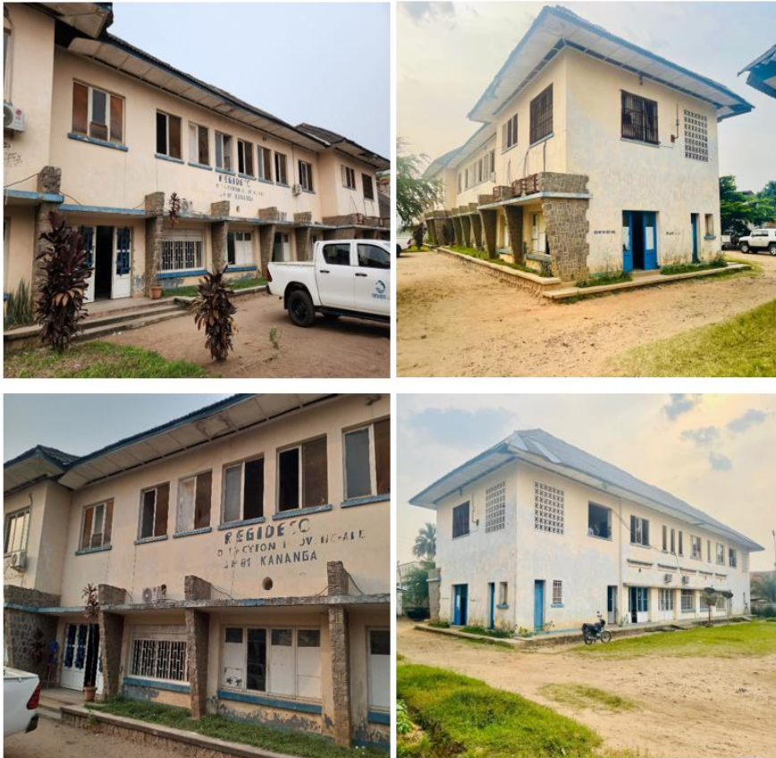
Photo 1 : Bâtiment principal (Bureau du siège Régional)
